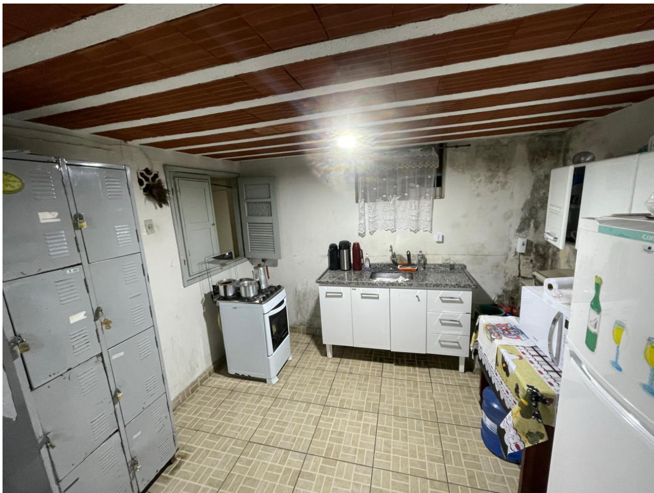
Foto 01 – 20/08/2025 – Cozinha da Câmara com paredes degradadas devido a infiltrações e umidades.
