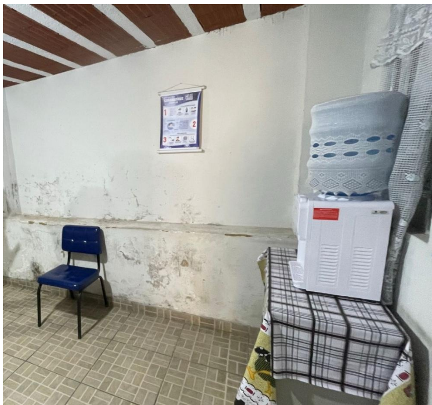
Foto 03 – 20/08/2025 – Parede da Cozinha com descascamento por umidade e infiltração.
