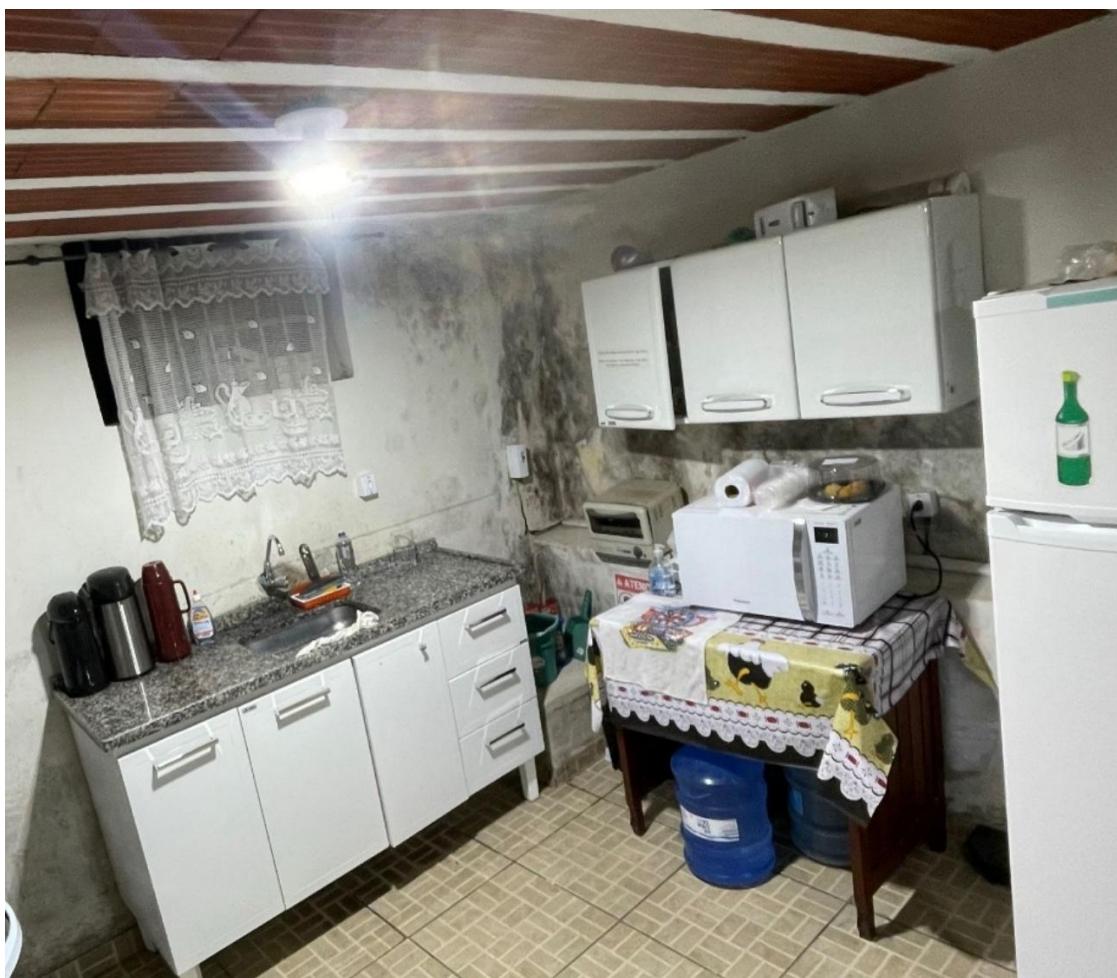
Foto 02 – 20/08/2025 – imagem em ângulo – Cozinha da Câmara com infiltração e umidade.
