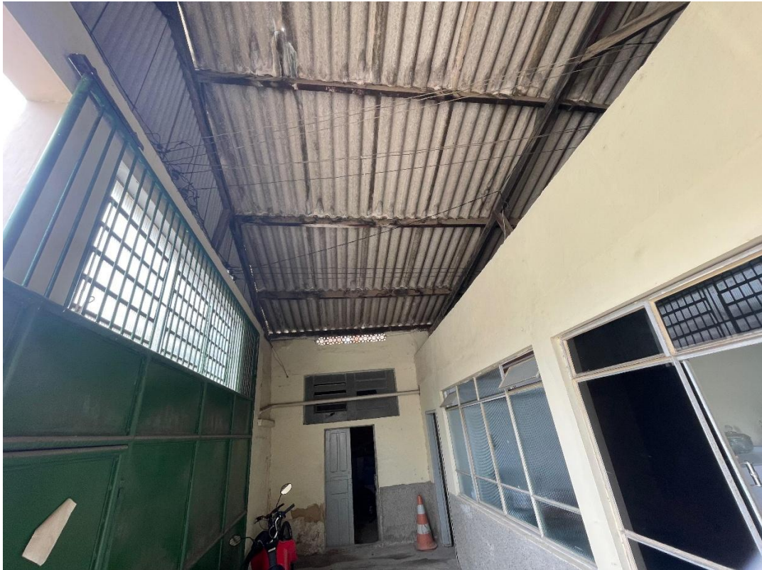
Foto 08 – 06/01/2026 – Vista da parte interna do telhado. Madeiramento e telhas com manchas de umidade e infiltração. Fiação elétrica exposta.
