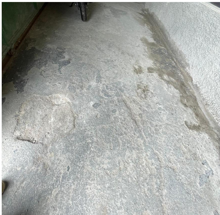
Foto 32 – 06/01/2026 – Parte interna do galpão. Desgaste e degradação do piso.
