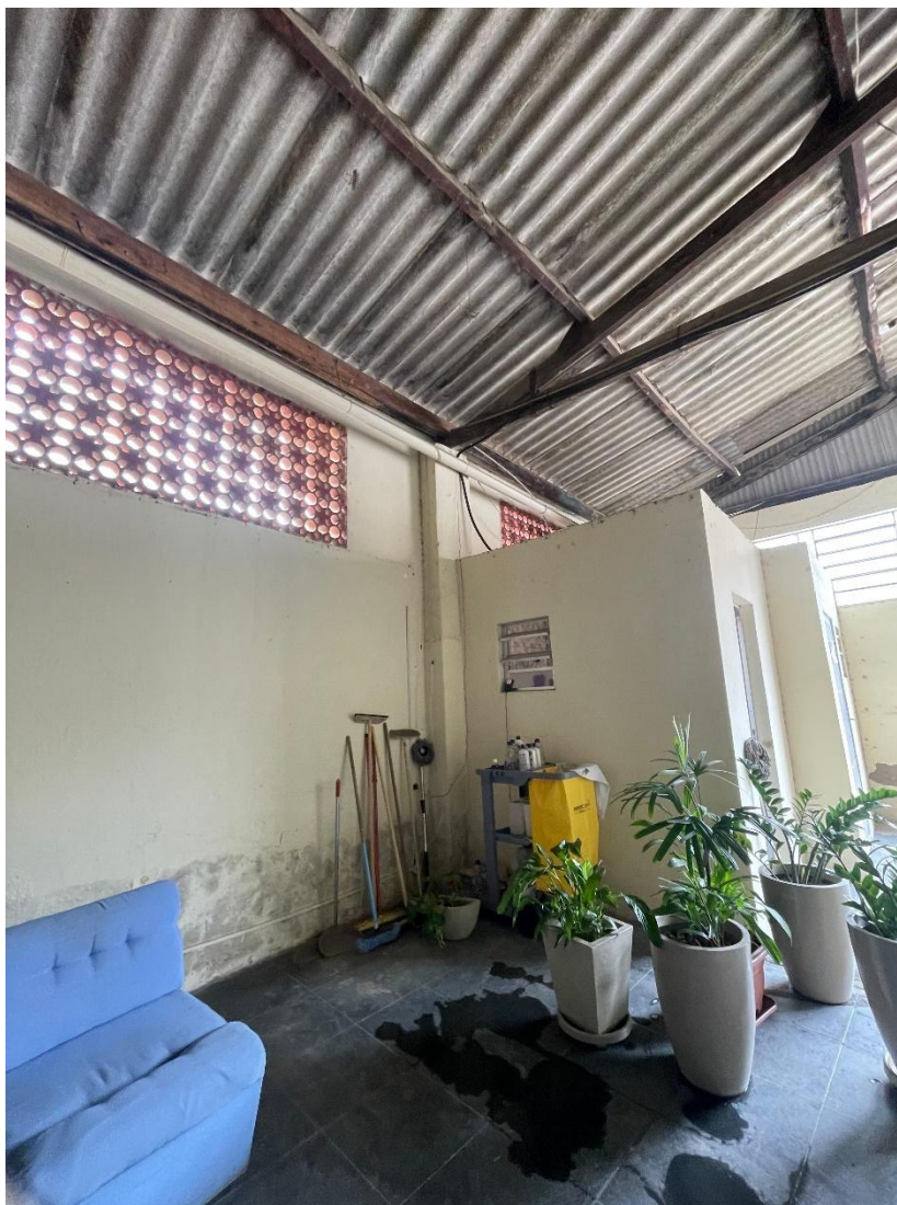
Foto 14 – 06/01/2026 – Vista da parte interna do telhado e área interna do galpão. Madeiramento e telhas com manchas de umidade e infiltração. Rachaduras nas telhas e fiação elétrica exposta. Paredes com formação de colonização biológica (fungos). Pintura totalmente manchada e descascando.
