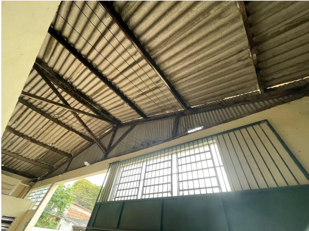
Foto 15 – 06/01/2026 – Vista da parte interna do telhado e área interna do galpão. Madeiramento e telhas com manchas de umidade e infiltração. Rachaduras nas telhas e fiação elétrica exposta.
