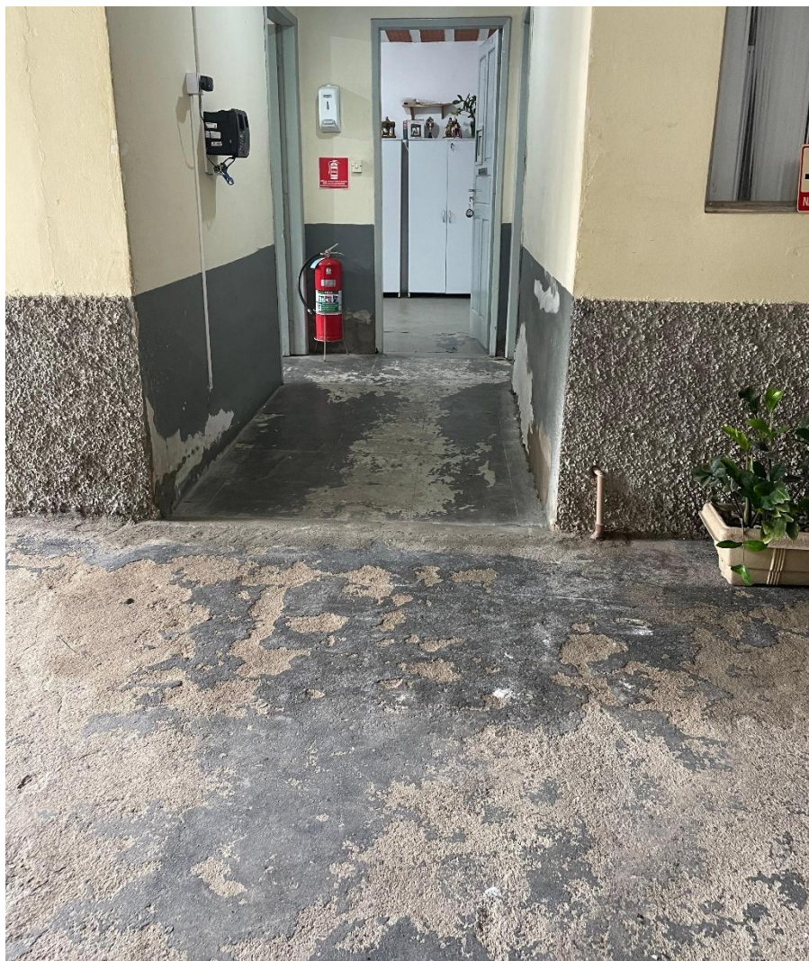
Foto 27 – 06/01/2026 – Parte interna do galpão. Degradação do piso. Paredes com pintura totalmente danificadas.
