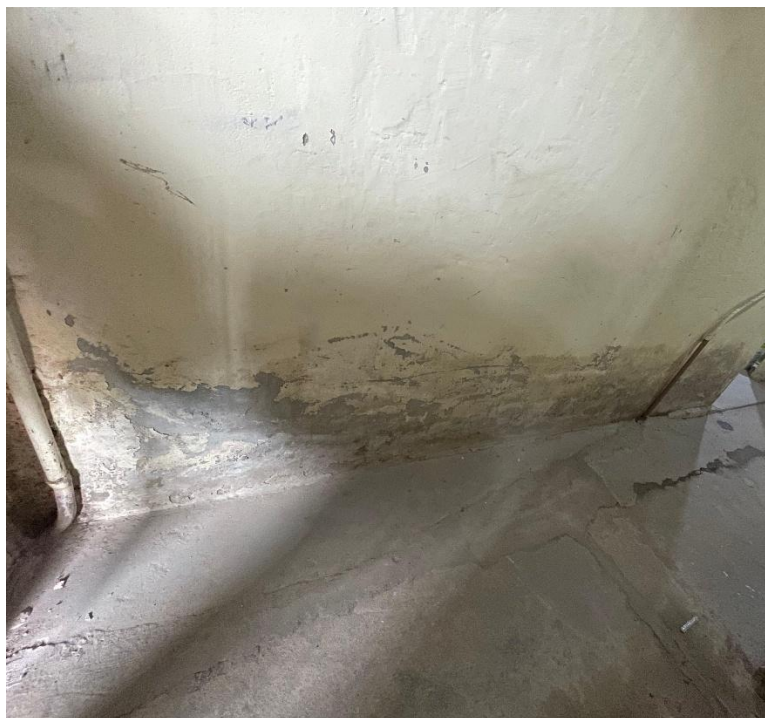
Foto 23 – 06/01/2026 – Parte interna do galpão. Paredes com manchas de umidade e formação de colonização biológica (fungos), degradação do piso. Pintura totalmente danificada, com descacamento e estufamento.
