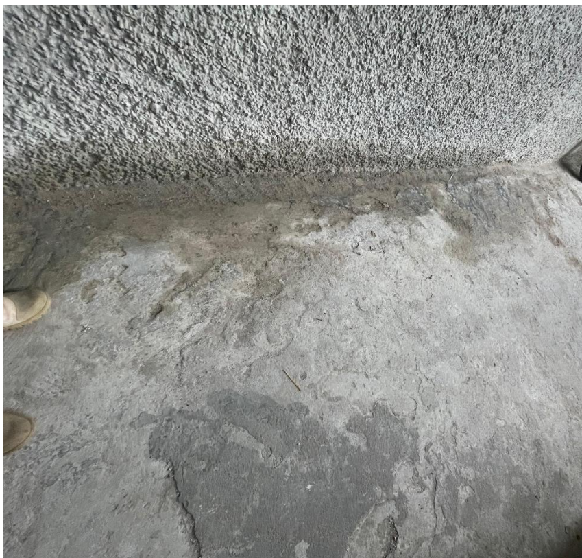
Foto 36 – 06/01/2026 – Parte interna do galpão. Degradação do piso e mancha de água na parede.
