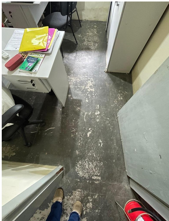
Foto 29 – 06/01/2026 – Parte interna do galpão. Degradação do piso. Mancha da água na parede do fundo.
