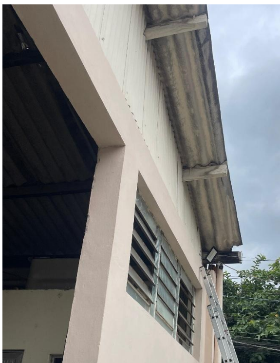
Foto 05 – 06/01/2026 – Vista da lateral direita do telhado. Madeiramento deteriorado e manchas de umidade e infiltração.
