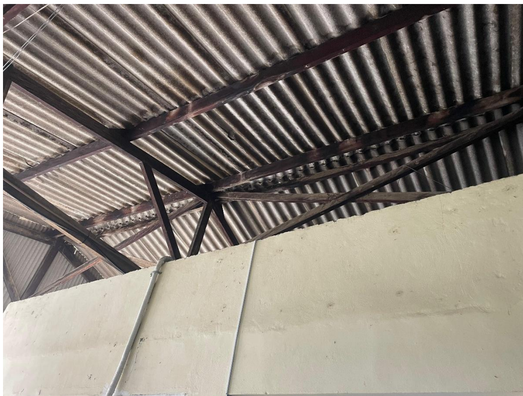
Foto 10 – 06/01/2026 – Vista da parte interna do telhado. Madeiramento e telhas com manchas de umidade e infiltração. Pintura manchada, desbotada e descascada. Rachaduras nas telhas e fiação elétrica exposta.
