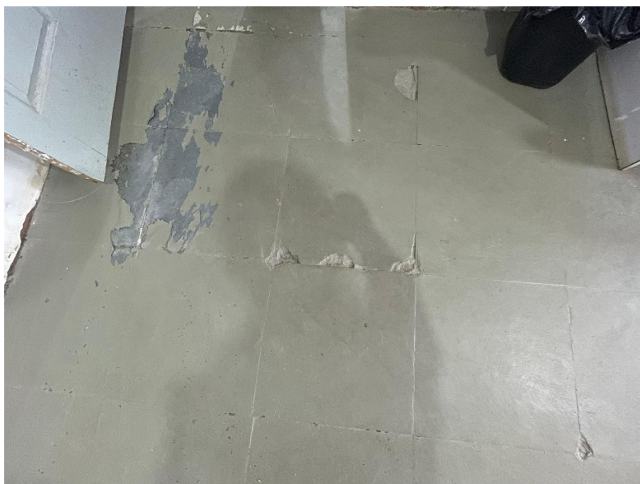
Foto 31 – 06/01/2026 – Parte interna de sala do galpão. Desgaste e degradação do piso por umidade.
