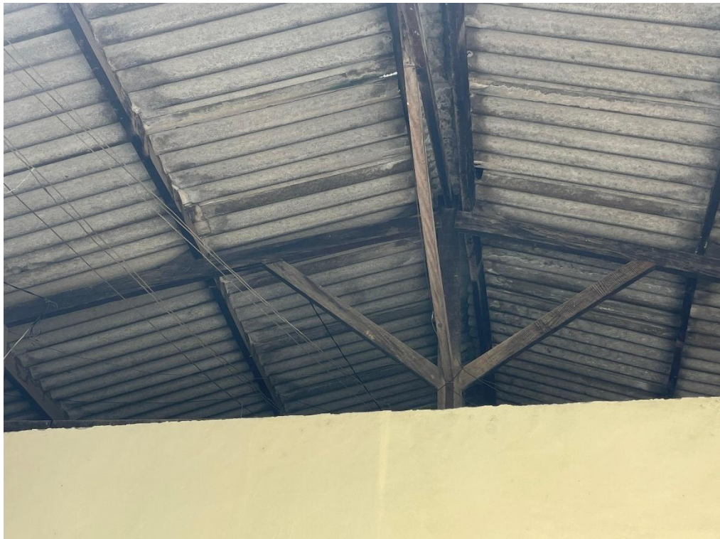
Foto 07 – 06/01/2026 – Vista da parte central interna do telhado. Manchas de infiltração e diversas rachaduras nas telhas.
