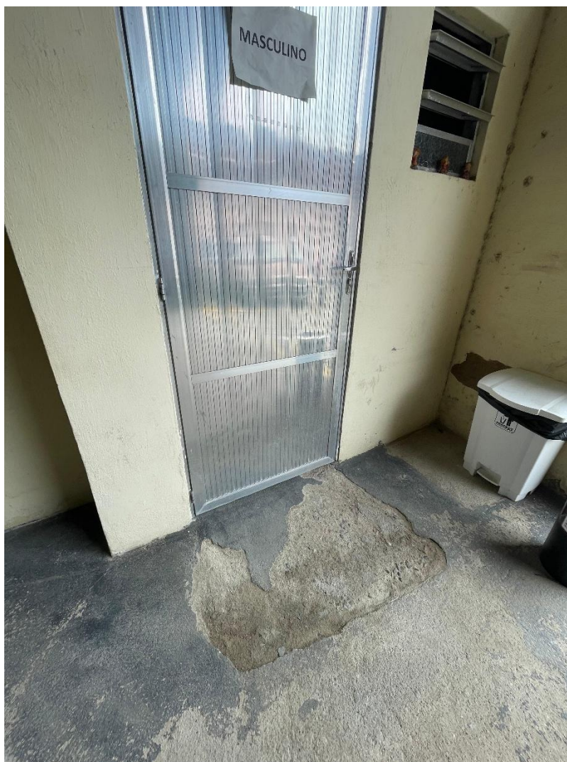
Foto 33 – 06/01/2026 – Parte interna do galpão. Desgaste degradação do piso.
