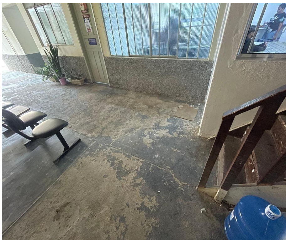
Foto 25 – 06/01/2026 – Parte interna do galpão. Degradação do piso.
