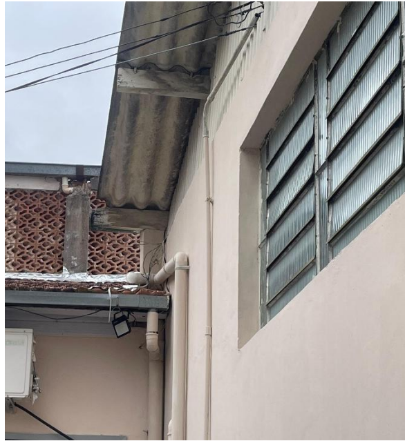
Foto 06 – 06/01/2026 – Vista lateral esquerda do telhado. Madeiramento deteriorado e manchas de umidade e infiltração.
