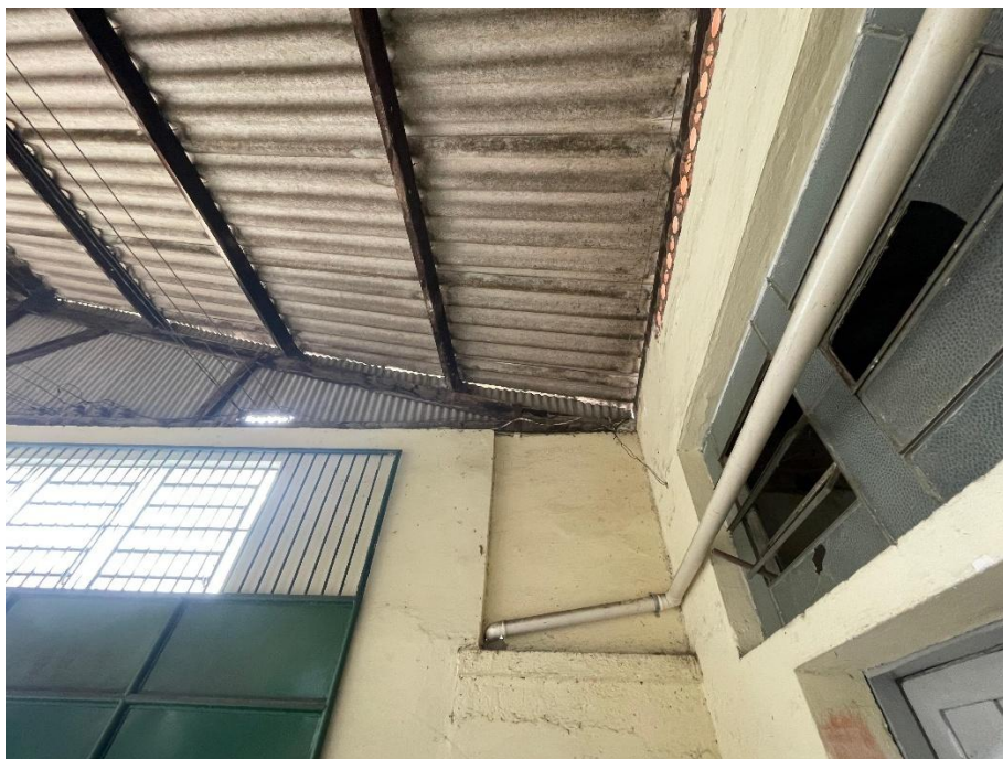
Foto 11 – 06/01/2026 – Vista da parte interna do telhado. Madeiramento e telhas com manchas de umidade e infiltração. Pintura antiga, com manchas de umidade descascamento. Rachaduras nas telhas e fiação elétrica exposta.
