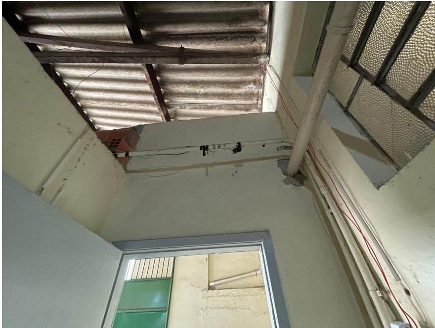
Foto 12 – 06/01/2026 – Vista da parte interna do telhado. Madeiramento e telhas com manchas de umidade e infiltração. Pintura descascada e manchada. Rachaduras nas telhas e fiação elétrica exposta.
