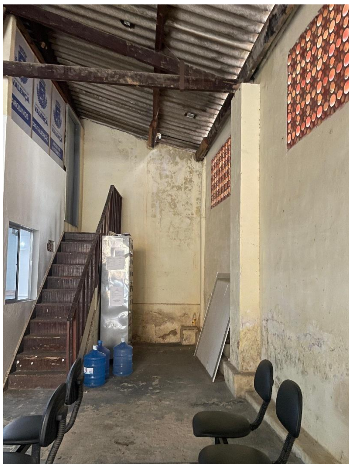
Foto 22 – 06/01/2026 – Parte interna do galpão. Paredes com manchas de umidade e formação de colonização biológica (fungos), degradação do piso. Pintura totalmente danificada.
