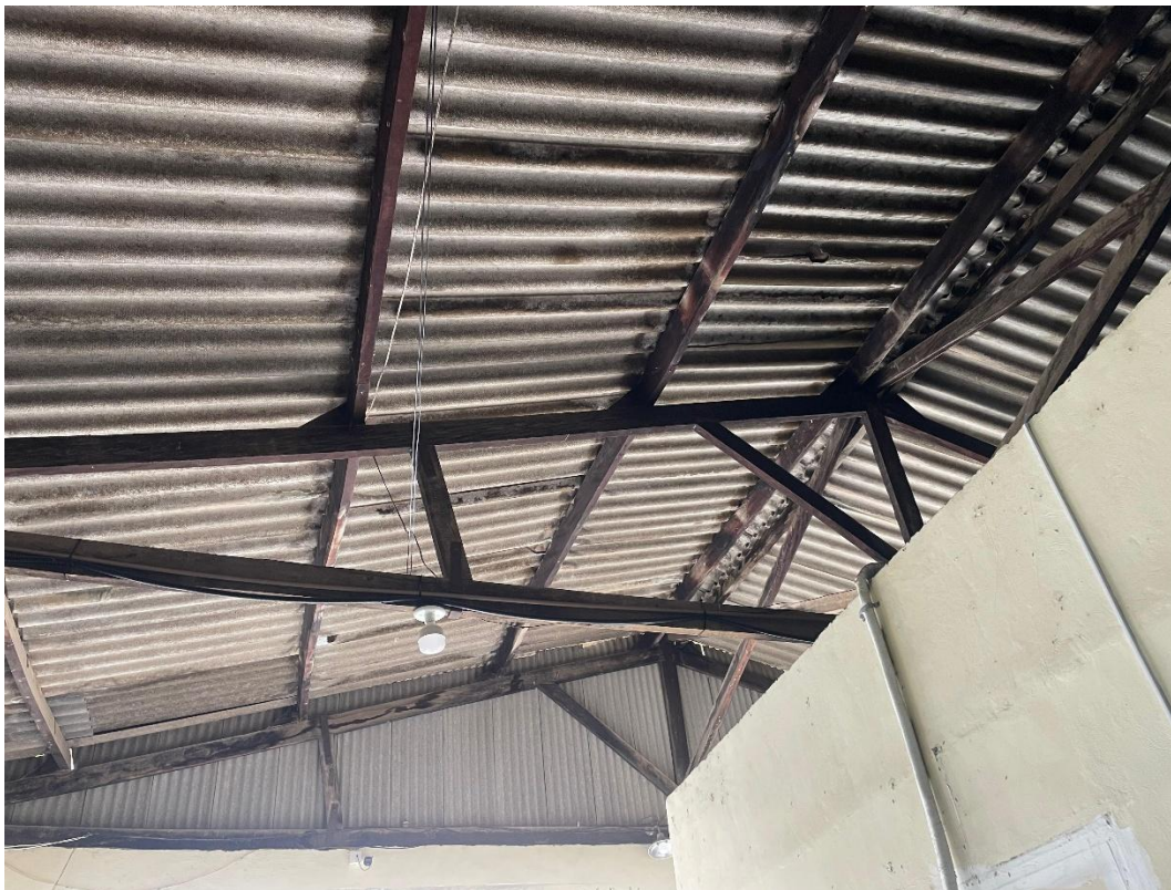
Foto 09 – 06/01/2026 – Vista da parte interna do telhado. Madeiramento e telhas com manchas de umidade e infiltração. Fiação elétrica exposta.
