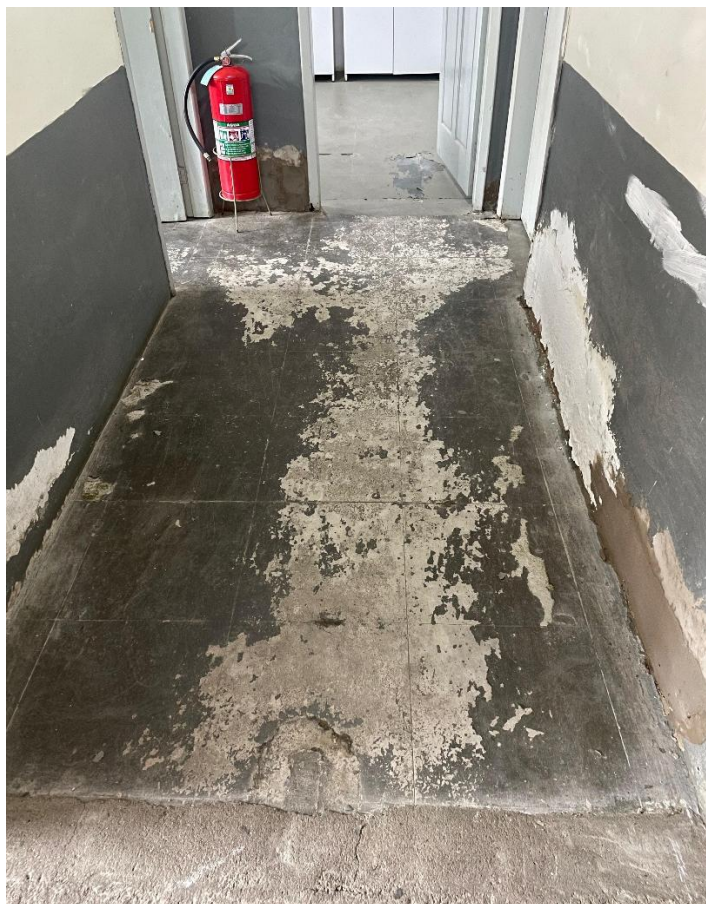
Foto 28 – 06/01/2026 – Parte interna do galpão. Degradação do piso.
