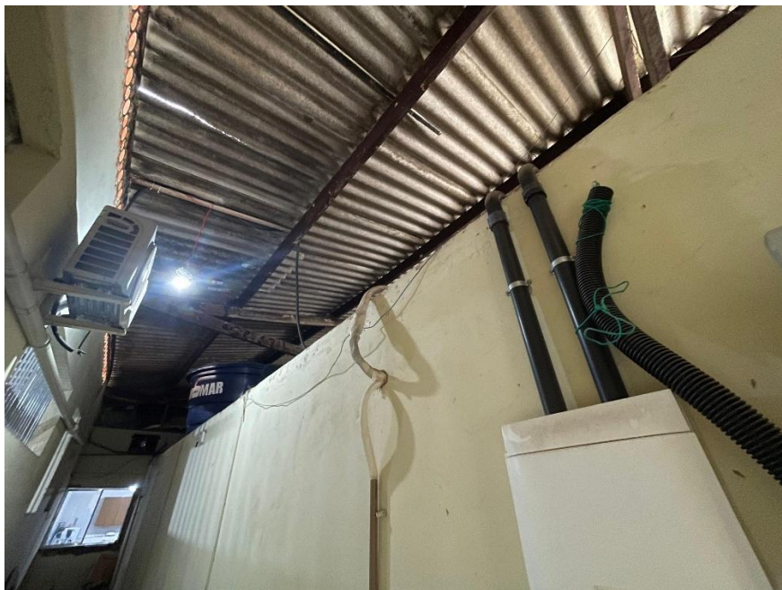
Foto 13 – 06/01/2026 – Vista da parte interna do telhado. Madeiramento e telhas com manchas de umidade e infiltração. Rachaduras nas telhas e fiação elétrica exposta.
