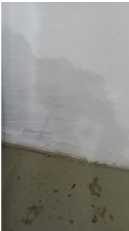
Foto 21 – 02/01/2026 – Vista da parte interna de sala do galpão. Altura de 48 cm, onde a água chegou na parede de uma sala.
