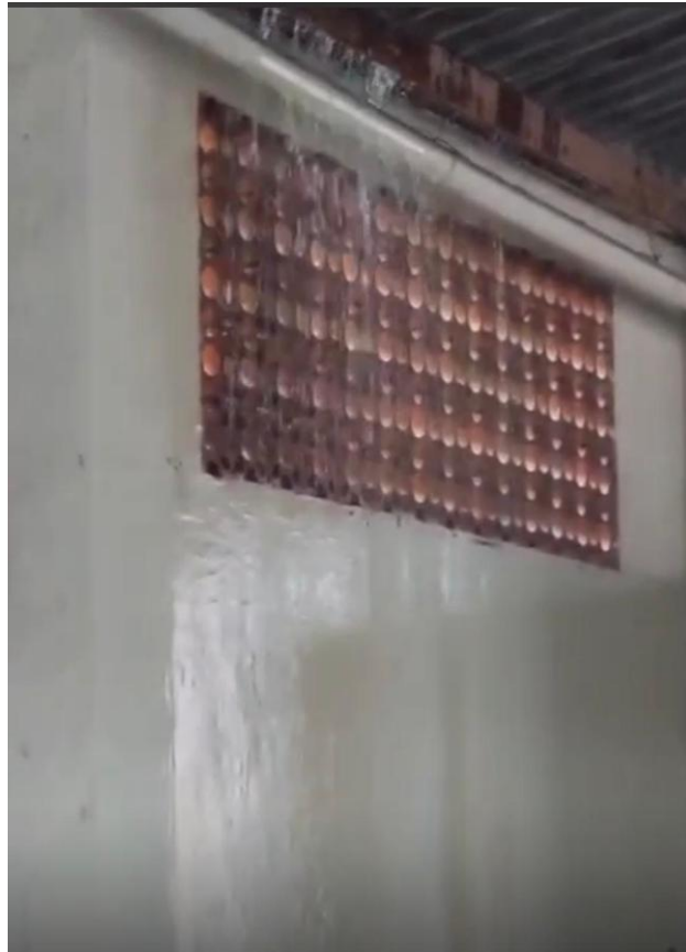
Foto 17 – 02/01/2026 – Vista da parte interna do telhado e área interna do galpão. Momento em que a chuva entrava pela lateral do telhado e inundava a área interna e salas.
