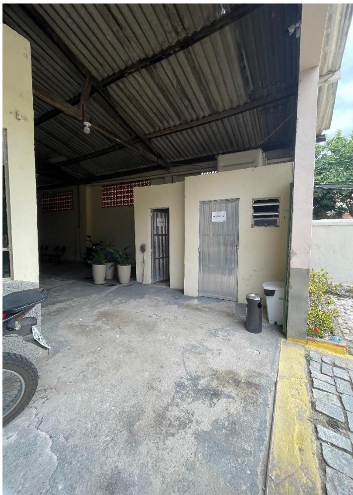
Foto 35 – 06/01/2026 – Parte interna do galpão. Degradação do piso, telhas rachadas e quebradas, assim como madeiramento com manchas de infiltração, e fiação elétrica exposta.
