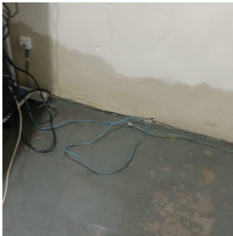
Foto 20 – 02/01/2026 – Vista da parte interna de sala do galpão. Altura de 40 cm, aonde a água chegou na parede de uma sala. Pintura totalmente danificada.
