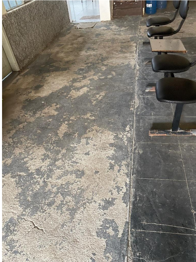
Foto 34 – 06/01/2026 – Parte interna do galpão. Degradação do piso.
