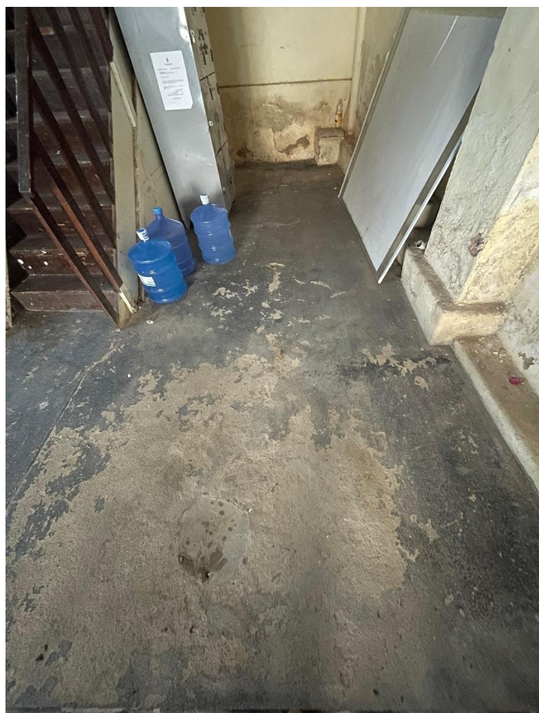
Foto 26 – 06/01/2026 – Parte interna do galpão. Paredes com manchas de umidade e formação de colonização biológica (fungos), degradação do piso. Pintura totalmente danificada.
