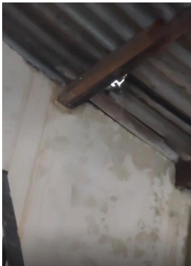
Foto 18 – 02/01/2026 – Vista da parte interna do telhado e área interna do galpão. Momento em que a chuva entrava pela lateral do telhado e inundava a área interna e salas. Pintura manchada e descascando.
